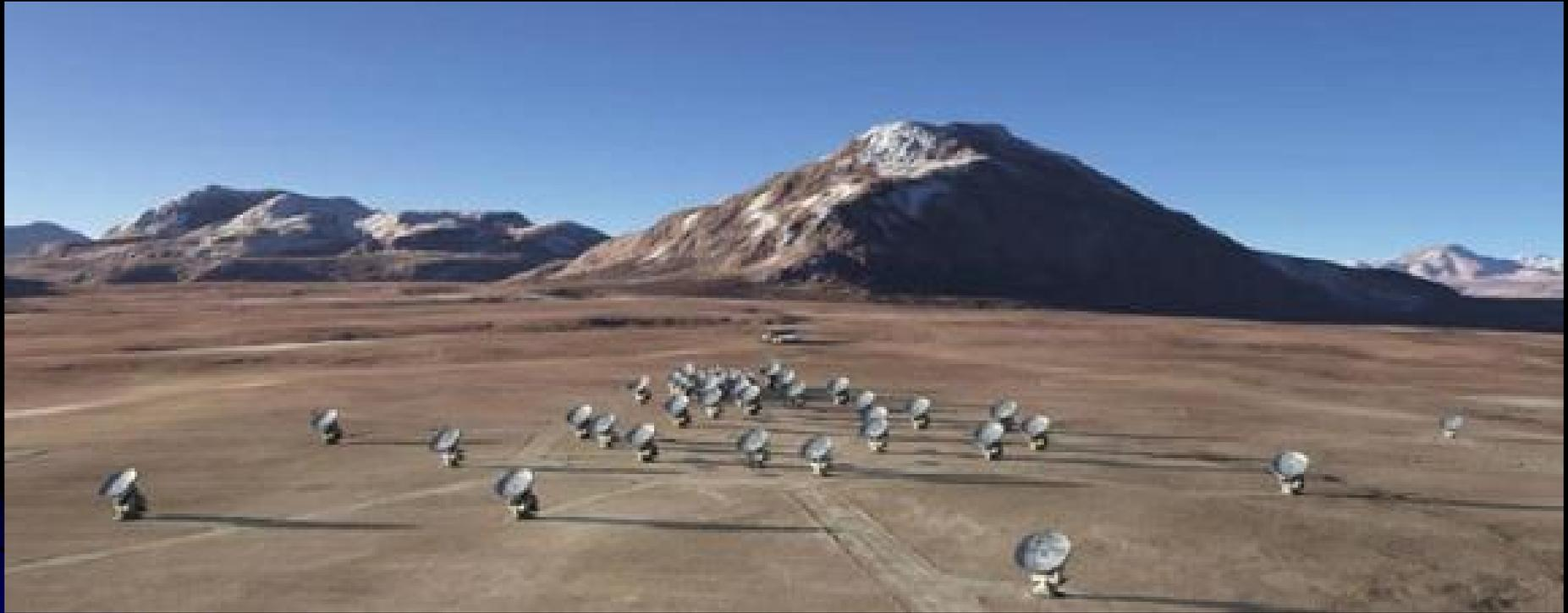
观测波段在**0.3至9.6mm**的波长，空间分辨率**0.01''**，“视力”是哈勃望远镜的**10倍**。口径**12米**的**54座**、口径**7米**的**12座**组成。
